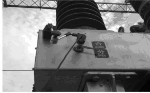
35KV SF6 开关传感器安装
