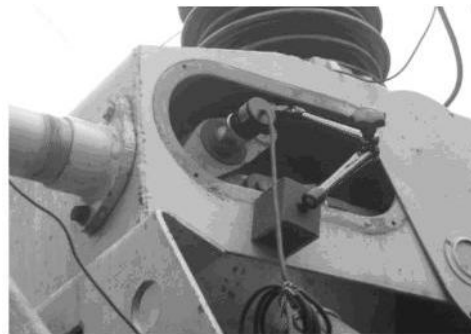
110KV SF6 开关传感器安装
